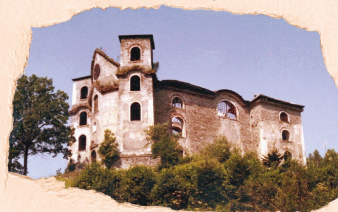
Původně opuštěný a poničený kostel v Neratově dnes díky nové fasádě a skleněné střechě září do širého kraje.
